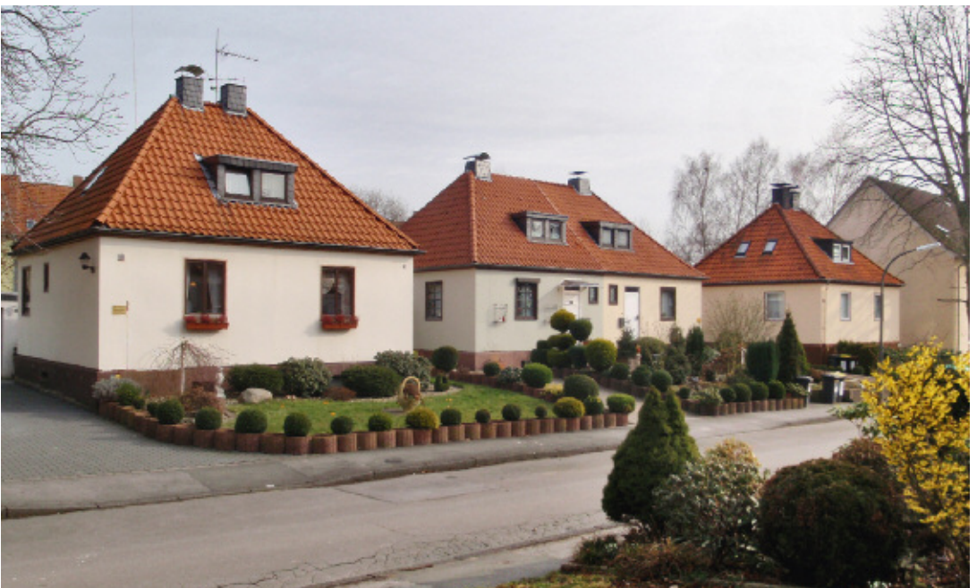
1 Dortmund-Eving, An den Stahlhäusern 11–5. Gesamtansicht Februar 2009.
