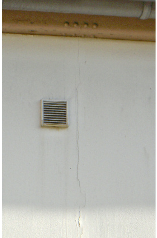
2 Dortmund-Eving, An den Stahlhäusern 11. Detail der Stahlfassade Oktober 2007.
